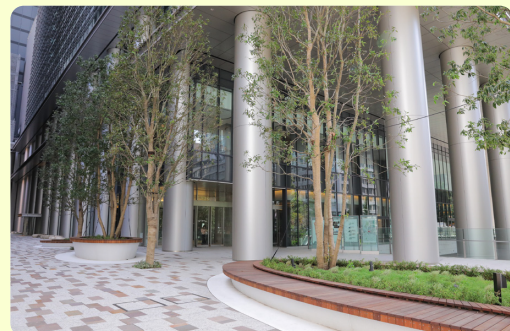
立ち上がりを設置した植栽
