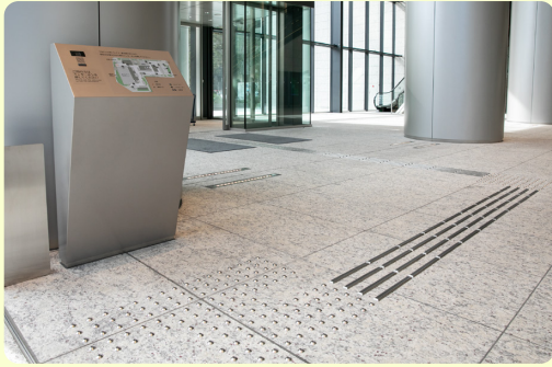
点字ブロックを設置した東エントランス
