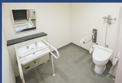
●車いす対応トイレ
